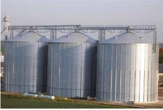
Aus verzinktem Wellblech. Statische Berechnung nach Eurocode. Senkrechte außenliegende Stützen in ca. 1,4 m Abstand
